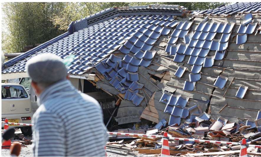
这是3月17日在日本福岛县国见町拍摄的倒塌的房屋。新华社/共同社
