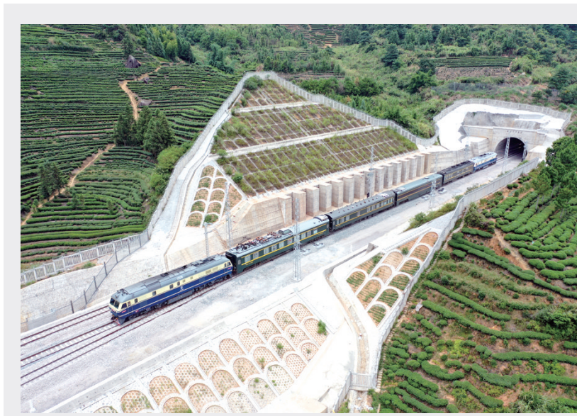
昨日,衢宁铁路福建段启动试运行综合动态测试,对轨道、通信、信号、电力及牵引供电等各系统性能及状态进行测试和试验,确保各系统达到设计要求,具备开通条件,为衢宁铁路正式开通运营提供科学依据。图为一列综合检测列车从衢宁铁路咸村二号隧道驶出。
