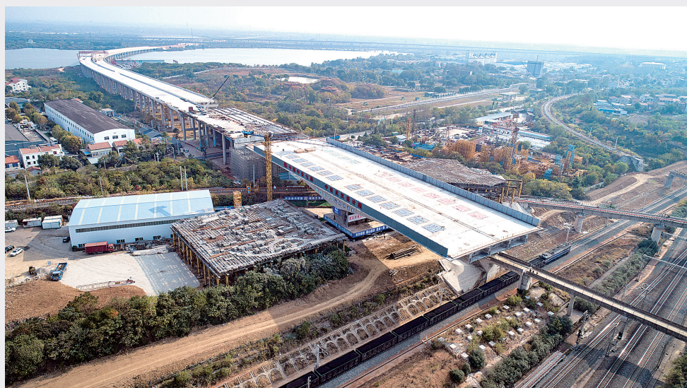
昨日凌晨,一座3.3万吨的梁桥完成87.47度转体顺利到位,标志着武汉市北四环跨铁路工程中的4座公路桥群转体启动。这4座转体桥位于1公里长度内,总重量超过11.5万吨,将跨越8条铁路线。率先完成转体的2号墩转体桥位于武汉市黄陂区松树岗村,剩余3座梁桥也将利用铁路养护“天窗期”开展转体,预计将在11月底前完成所有转体施工任务。 新华社发
