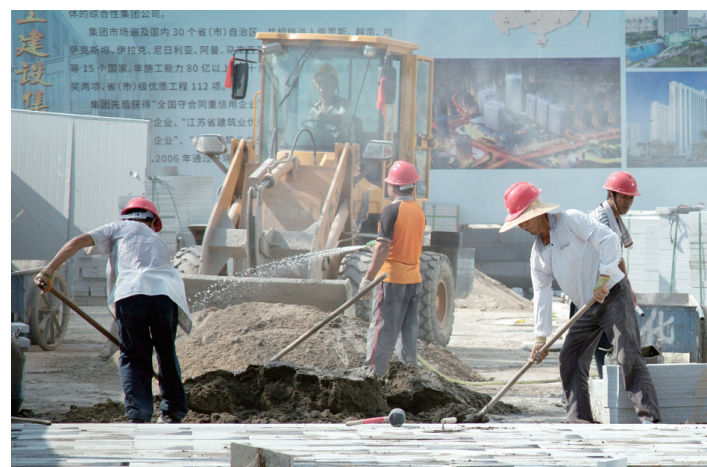
烈日下的建筑工 田冰 摄
