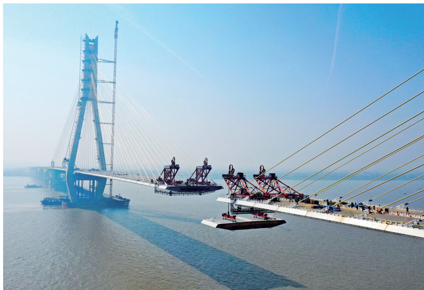
日前,由在镇央企中交二航局施工的安徽池州长江公路大桥正在吊装钢箱梁。据悉,该桥主桥长5.8千米,为双塔双索面斜拉桥,主跨828米,起自池州市枞阳县会官镇,接建设中的北沿江高速公路,过江后止于池州市殷汇镇,接南沿江高速公路。大桥2014年开工建设,目前引桥部分已全部完工,预计3月底主桥合龙,6月底通车。 吴宙 杨贺 谢道韞 摄影报道
